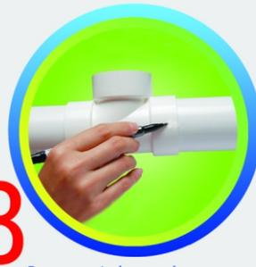
**3** Buat garis lurus dengan menggunakan spidol baik di socket fitting maupun di pipa untuk memudahkan penyambungan.
