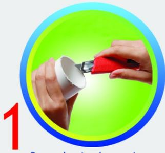
**1** Buang bagian kasar sisa potongan pipa dengan menggunakan pisau/cutter
