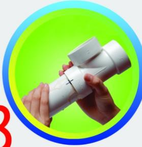
**8** Tahan pipa & socket selama 20 detik untuk menghindari slip.
