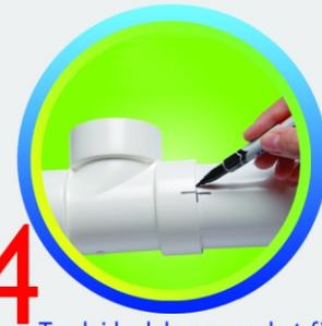
**4** Tandai kedalaman socket fitting di pipa. Lepaskan socket dari pipa
